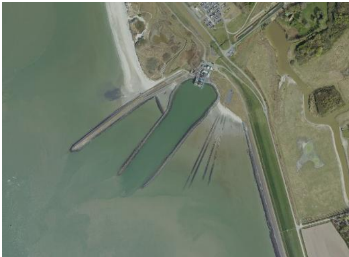
Figuur 6-38 Waterinlaat bij de huidige kerncentrale in Borssele (bron: Cyclomedia, 2025)
