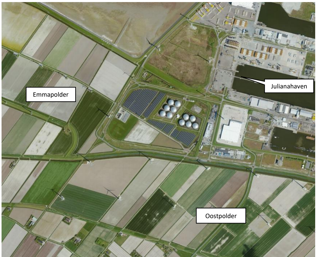
Figuur 4-8 Bovenaanzicht huidige situatie ter hoogte van alternatieven Eemshaven 1A en 1B (bron: Streetsmart, 2025)
