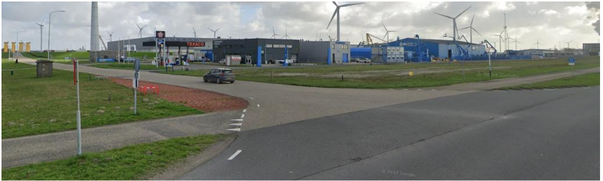
Figuur 6-4 Fietspad langs de Kwelderweg en Meeuwenstaartweg, voorbeeld kruising met Westereemsweg (bron: StreetSmart)
