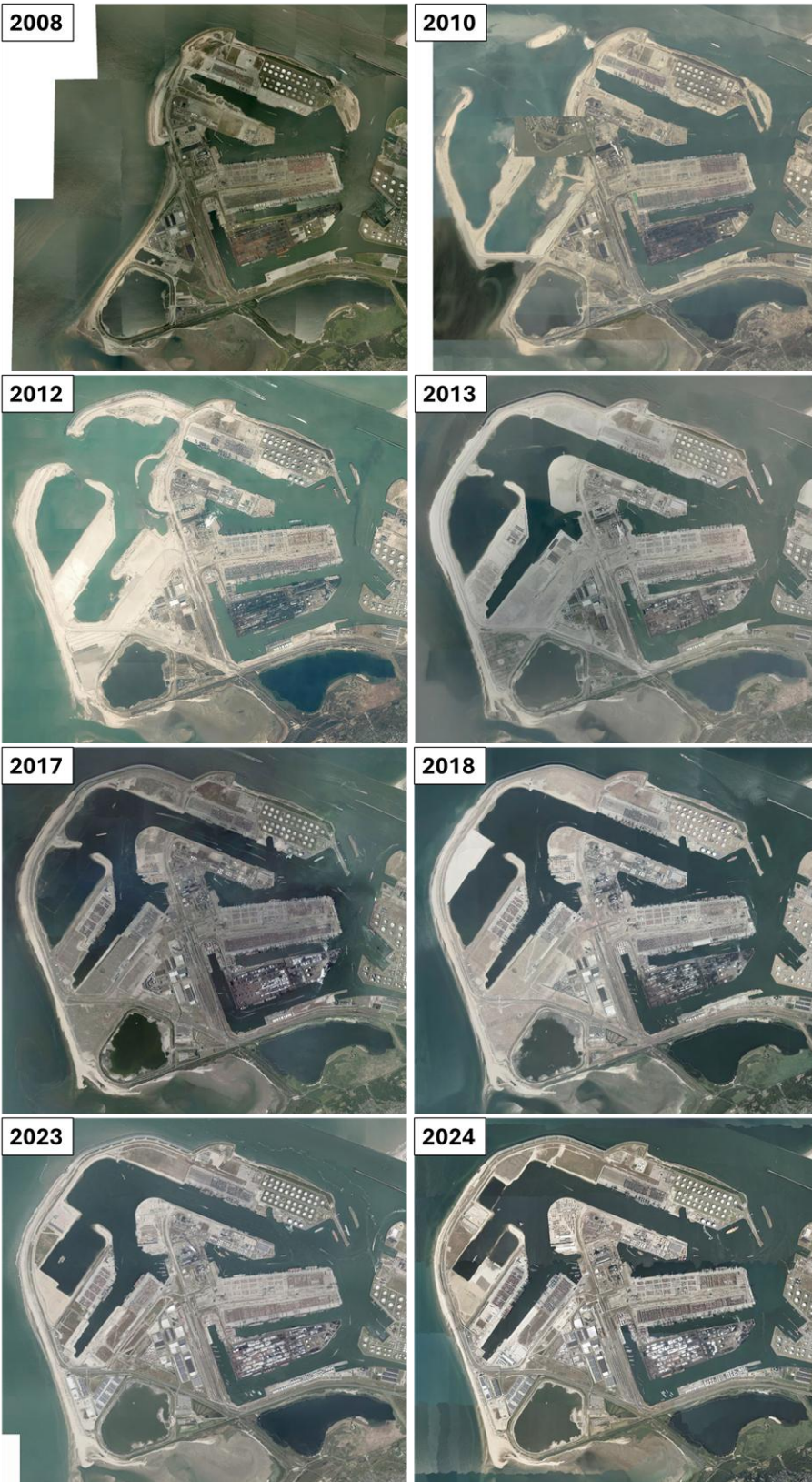
Figure 3-10 Satellite imagery of the construction of MV2. Source: https://luchtfototijdreis.nl/ , which uses images from "Esri Nederland, Kadaster" (voor 2006-2008), "Esri Nederland, Cyclomedia/Aerodata" (voor 2009-2011), "Esri Nederland, © aerodata, powered by CycloMedia" (voor 2012 t/m 2015), "Esri Nederland, Beeldmateriaal.nl" (voor 2016 t/m 2020), Beeldmateriaal.nl" (voor 2020 t/m 2024).
