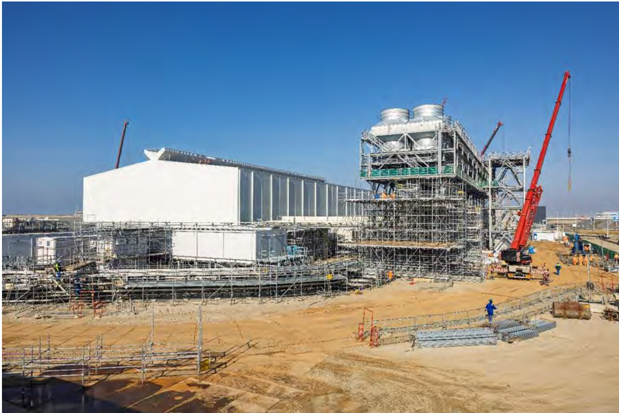
Foto: Holland Hydrogen 1 project in aanbouw.
