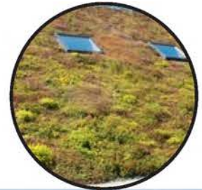
Groen sedum dak
