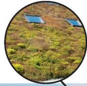
Groen sedum dak
