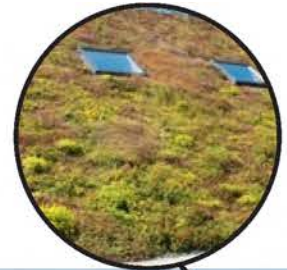
Groen sedum dak
