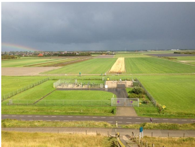
Afbeelding 3 – voorbeeld van een omheinde afsluiterlocatie
