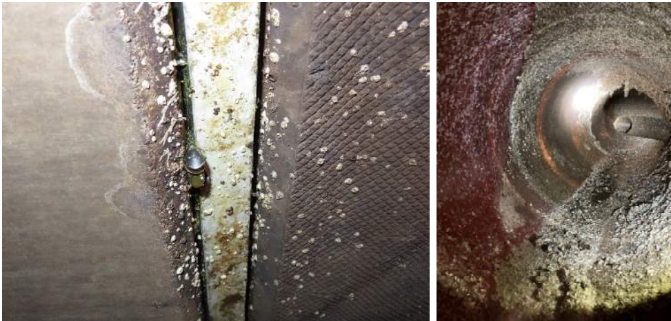
Figuur 2. Afzetting van biologische aangroei wordt beïnvloed door factoren als turbulentie en stroomsnelheid: links afzetting in een dilatatievoeg, en rechts aangroei patroon in een leidingdeel (foto credits: Pecten Aquatic).
