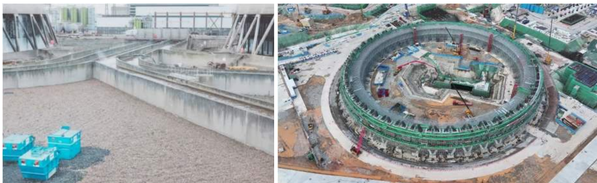
Figuur 4. Voorbeeld van koeltoren complexiteit: links - aan/afvoer binnen het complex met koeltorens van de Drax energiecentrale (UK) (bron foto: Drax website); rechts - fundering van de mega-zeewaterkoeltorens (basis 175 m, hoogte 218 m) van de Lianjiang kerncentrale in China (1224 MWe/unit) (bron foto: WNN website).
