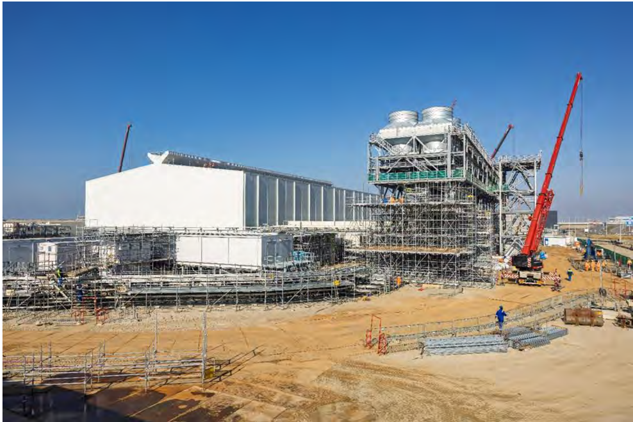
Foto: Holland Hydrogen 1 project in aanbouw.
