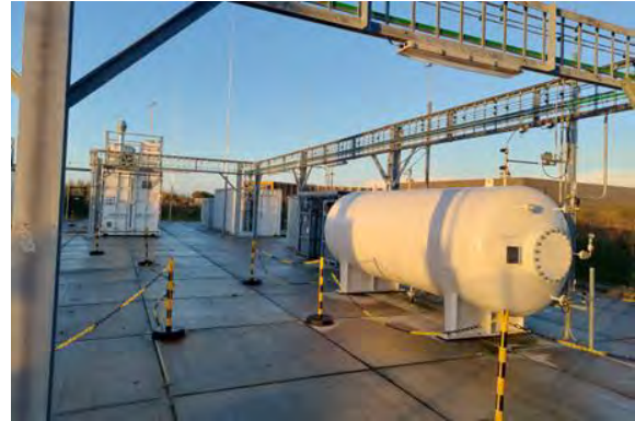
Foto: Elektrolyser en tussenopslag
