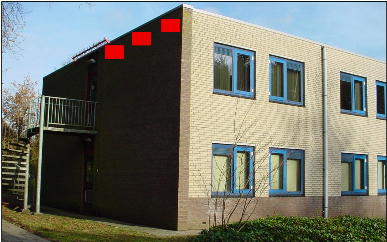
Figuur 5.8 Gebouw 25, kopgevel met locaties te plaatsen nestkasten voor gierzwaluw (rood).
