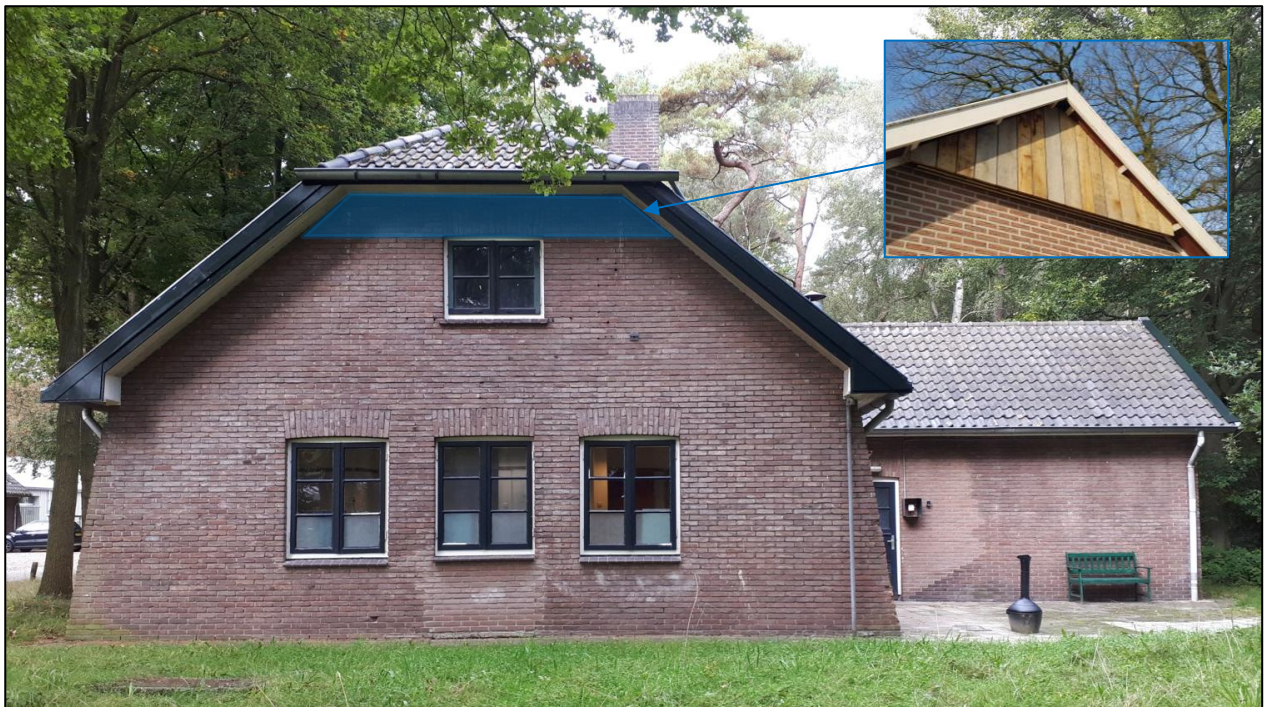
Figuur 5.4 Overzichtsfoto gebouw 63 waarbij de dubbel laagse gevelbetimmering in de nok van de kopgevels wordt aangebracht.
