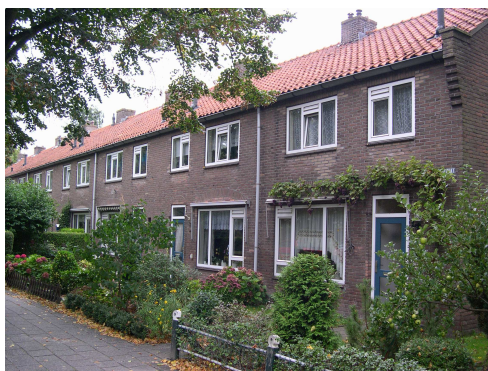
Figuur 1: Naoorlogse rijtjeswoningen die aan energiezuinige renovatie toe zijn [foto: Joost Paauw, ECN].
