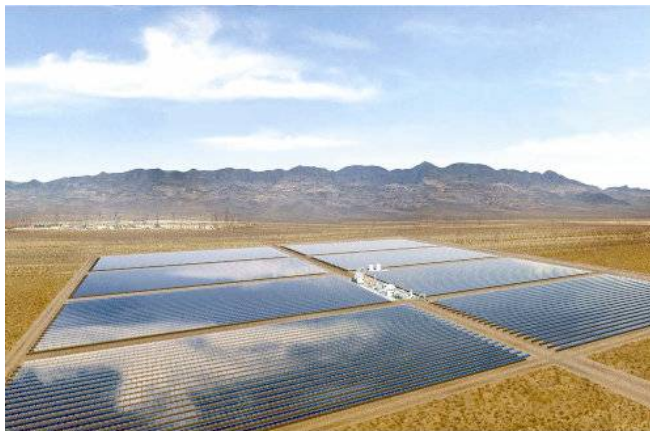
Figuur 8.6: PV zonnepanelen in woestijn bij Nevada voor opwekking van duurzame elektriciteit [http://pesn.com].
