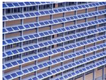
Figuur 6.7: PV op het dak [20]. Figuur 6.8: PV als zonwering [21].
