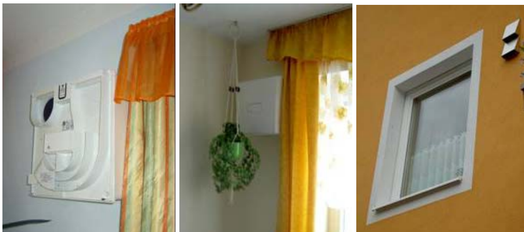
Figuur 4.14: WTW unit zonder afdekkap en WTW unit in gebruik, binnenzijde en buitenzijde [foto's: Chiel Boonstra].
