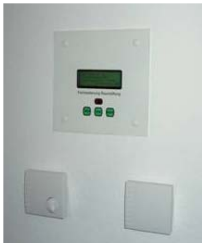
Figuur 7.5: Ventilatie-regeling voor woning, naast de kamerthermostaat in 3-literhuis in Ludwigshafen, Duitsland [Foto: Chiel Boonstra].
