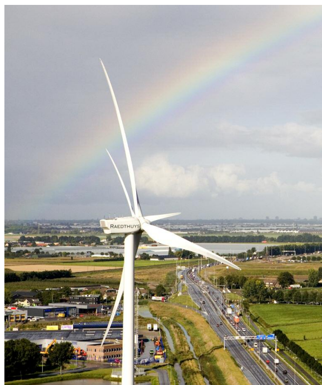
Windturbines op bedrijventerrein Distriport, Waddinxveen (bron: Raedthuys)
