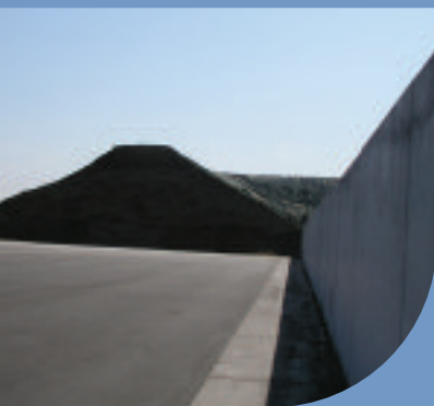
Ingekuilde mais dient als grondstof voor de vergistingsinstallatie
