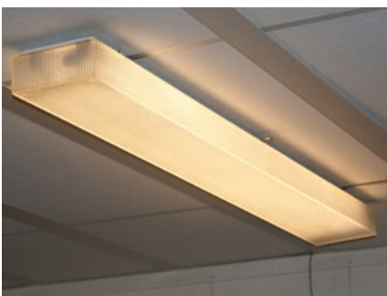
Opbouwarmatuur 2 x 36 W met prisma kap.
