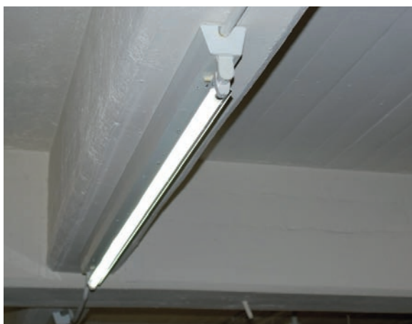
Voorbeeld van toepassing oude tl-armatuur met T8-lamp.
