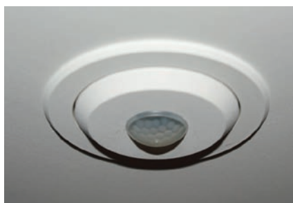
Aan het plafond te plaatsen detector.
