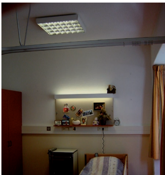
Zo moet het niet: opbouwarmatuur (6 x 18 W) in combinatie met leesverlichting (1 x 36 W).
