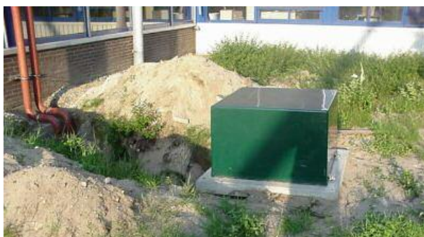
Putbehuizing van de monobron naast de fabriekshal
