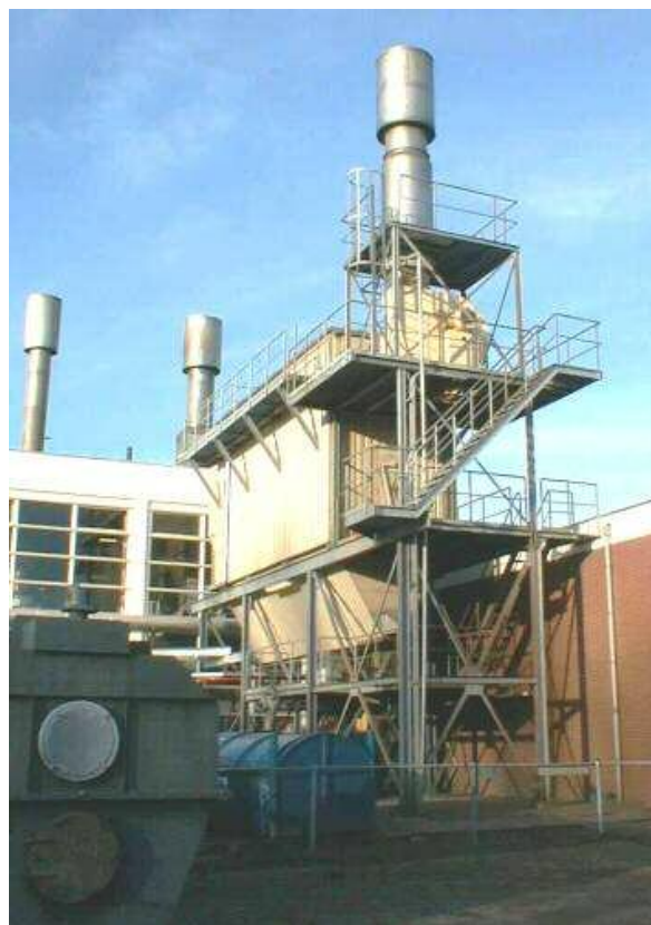
Biomassaketel met vliegfilter
