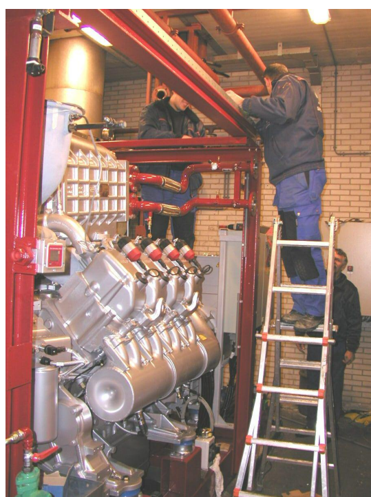
Eén van de twee biogasmotoren tijdens de opbouw
