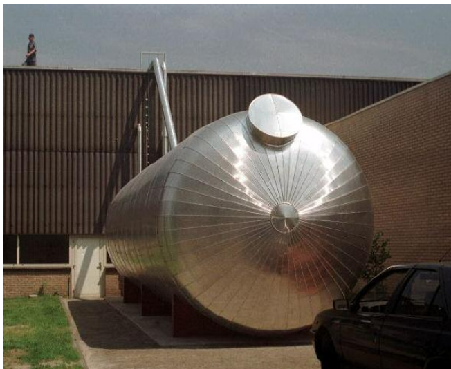
Het warmteopslag- en terugloopvat
