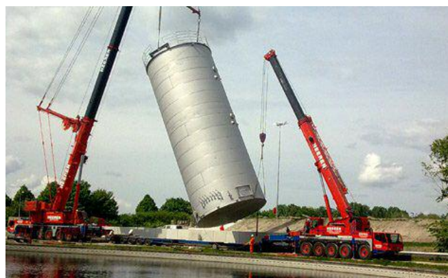
Plaatsing van een methaanreactor
