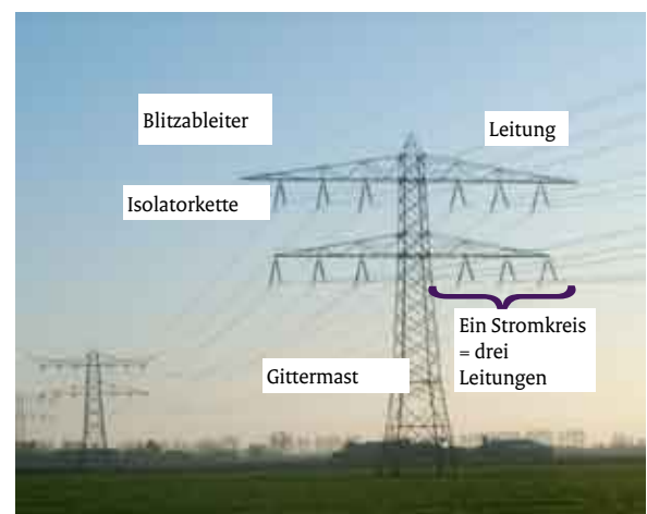
Beispiel für einen Gittermast mit 4 Stromkreisen
