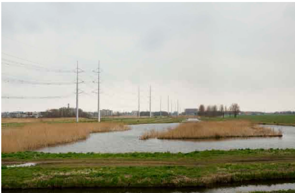
Abbildung 4.12 Wintrack-Mast gemäß Entwurf für die Randstad 380 kV-Leitung
